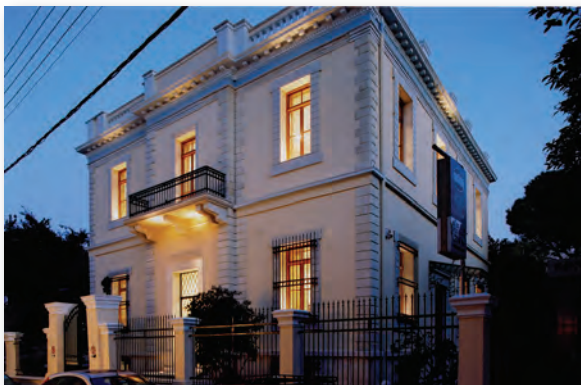
60. Εξωτερική όψη υποκαταστήματος Ρεθύμνου.
