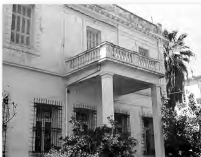
50. Πρόσοψη υποκαταστήματος Ρεθύμνου.
