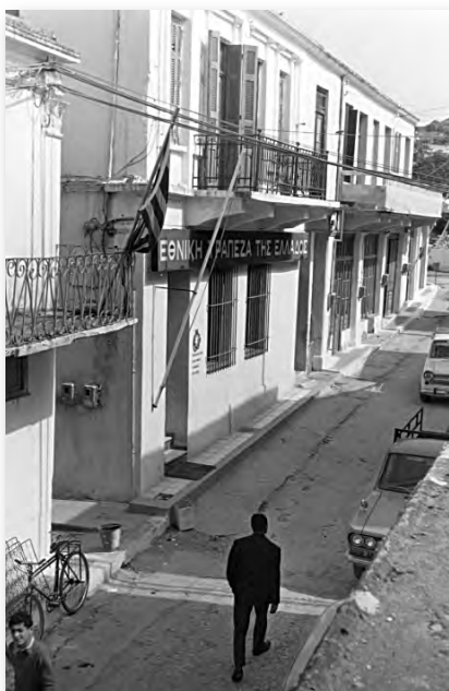
56. Εξωτερική όψη υποκαταστήματος Μοιρών.
