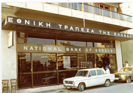
61. Πρόσοψη υποκαταστήματος Πλατείας Κορινθίου, Ηράκλειο.
