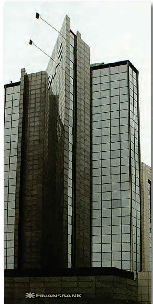
Το κεντρικό κατάστημα της Finansbank, θυγατρικής της ΕΤΕ, στην Κωνσταντινούπολη.
