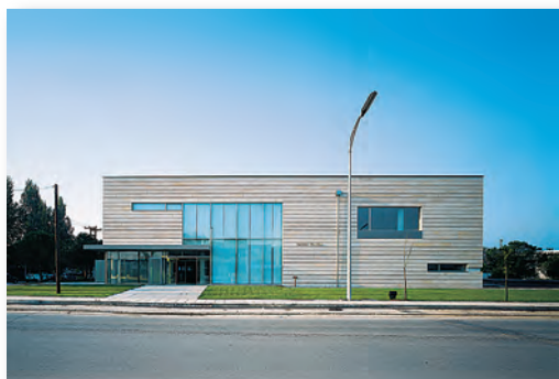
Το σύγχρονο κτήριο του υποκαταστήματος της Εθνικής Τράπεζας στη Σίνδο, κοντά στη Θεσσαλονίκη. Έργο του αρχιτεκτονικού γραφείου των Ειρ. Σακελλαρίδου και Μ. Παπανικολάου.
