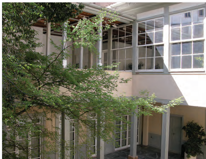
Η εσωτερική αυλή του κτηρίου του Μορφωτικού Ιδρύματος Εθνικής Τραπέζης, στην οδό Θουκυδίδου, Πλάκα. Ένα από τα ελάχιστα σωζόμενα κτήρια της οθωμανικής περιόδου.
