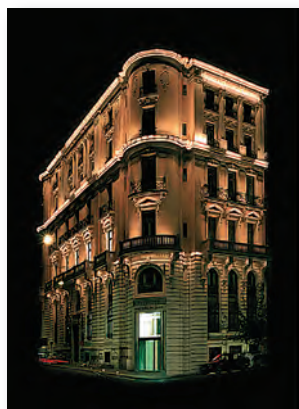
Το Μέγαρο Βάττη φωταγωγημένο. Αγοράστηκε από την Εθνική το 1970 και μετά την αναπαλαίωσή του στεγάζει τη Διεύθυνση Ναυτιλιακών Εργασιών και το Ναυτιλιακό Κατάστημα στον Πειραιά από το 2000.
