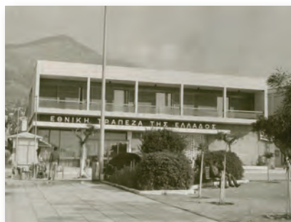
65. Πρόσοψη υποκαταστήματος Κυπαρισσίας, 1972.
