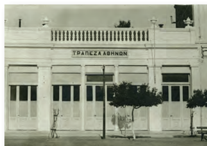
76. Πρόσοψη υποκαταστήματος Πύργου, Τράπεζας Αθηνών.
