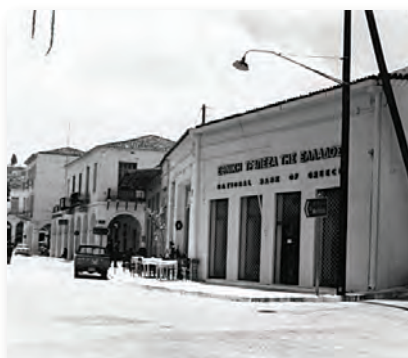
66. Άποψη υποκαταστήματος Πύλου από κεντρική οδό, 1972.
