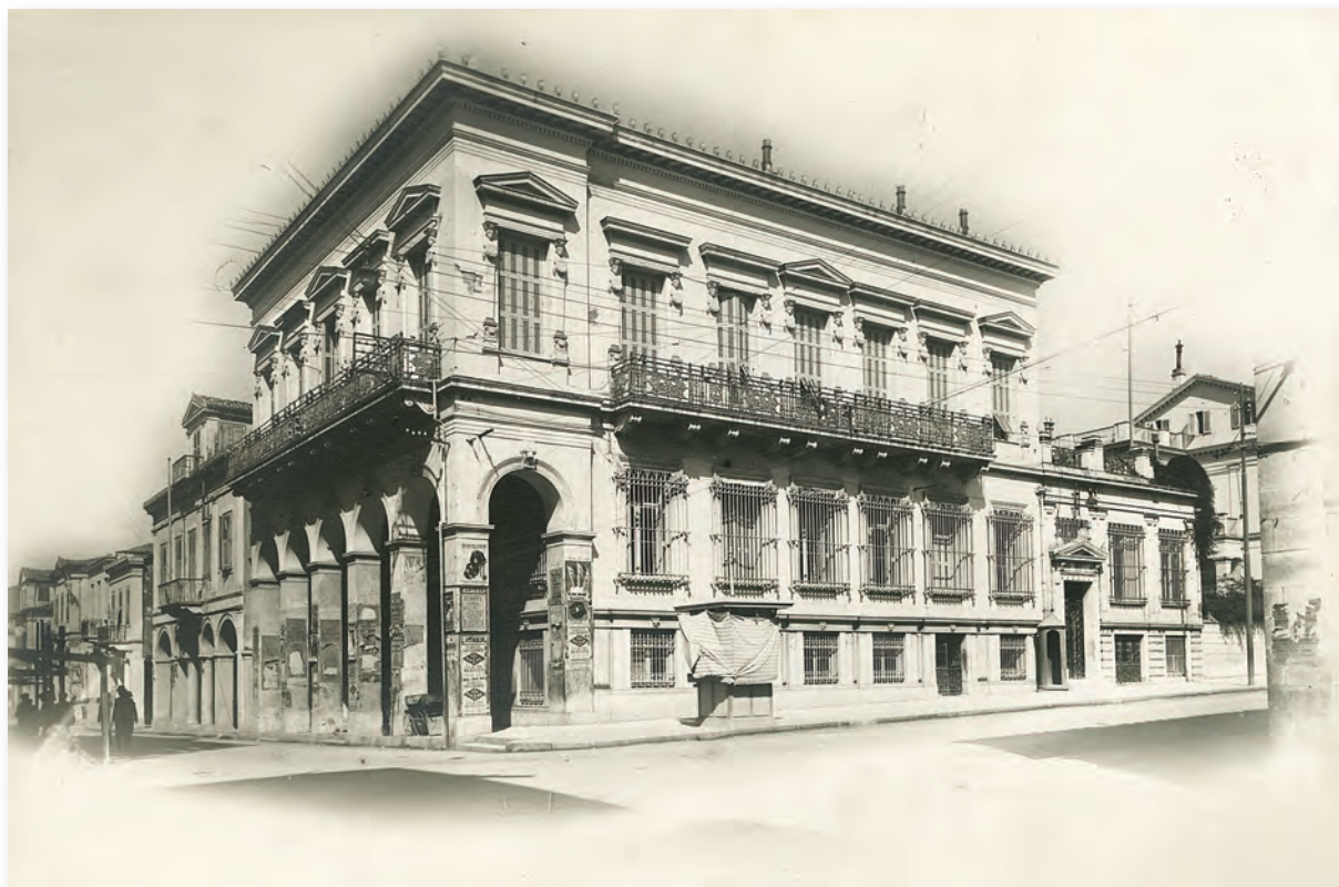
44. Εξωτερική όψη του υποκαταστήματος Πάτρας.
